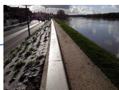
système amovible mis en place en travers de la rue sur berge à la limite des deux communes (en deçà de la côte de protection de la digue existante)
