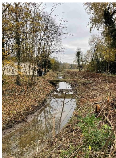
MOULIN DU RADET AVANT TRAVAUX
