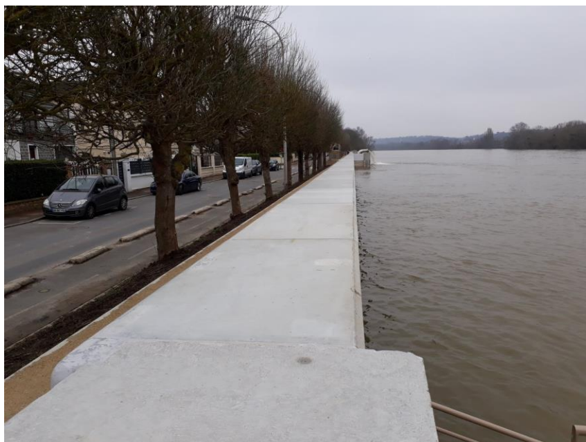
LA DIGUE DE MONTESSON
