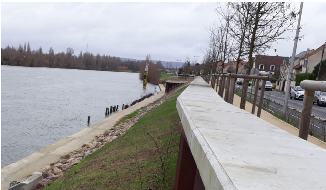
Section de digue courant de Montesson
