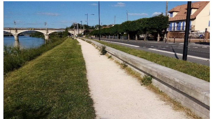
Section de digue courant de Sartrouville
